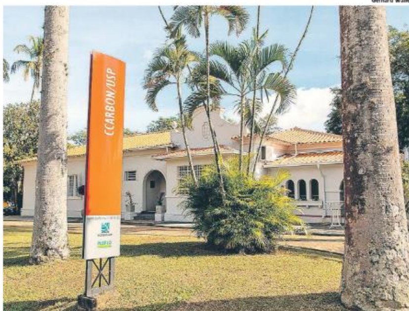
Centro Instalada no campus da Esalq, nova sede administrativa do CCARBON fortalece a USP como referência global em pesquisa sustentável
